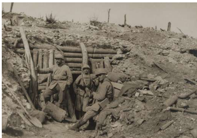
Abri français dans les carrières du bois de Vaux-Chapitre, juillet 1916. © La Contemporaine (Val.207/036)
