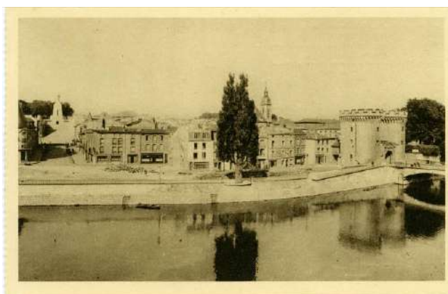
Le même quai de Londres, vu du Monument à la Victoire à la Porte Chaussée. (Coll. Mémorial de Verdun)
