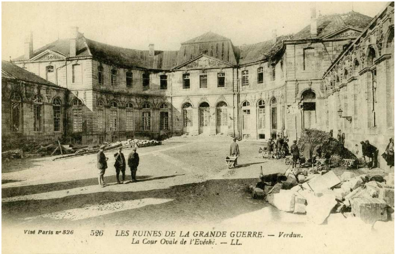
Travaux dans la cour du Palais épiscopal de Verdun. © Coll. Mémorial de Verdun
