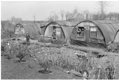
Maisons provisoires Nissen à Equancourt. © Library of Congress
