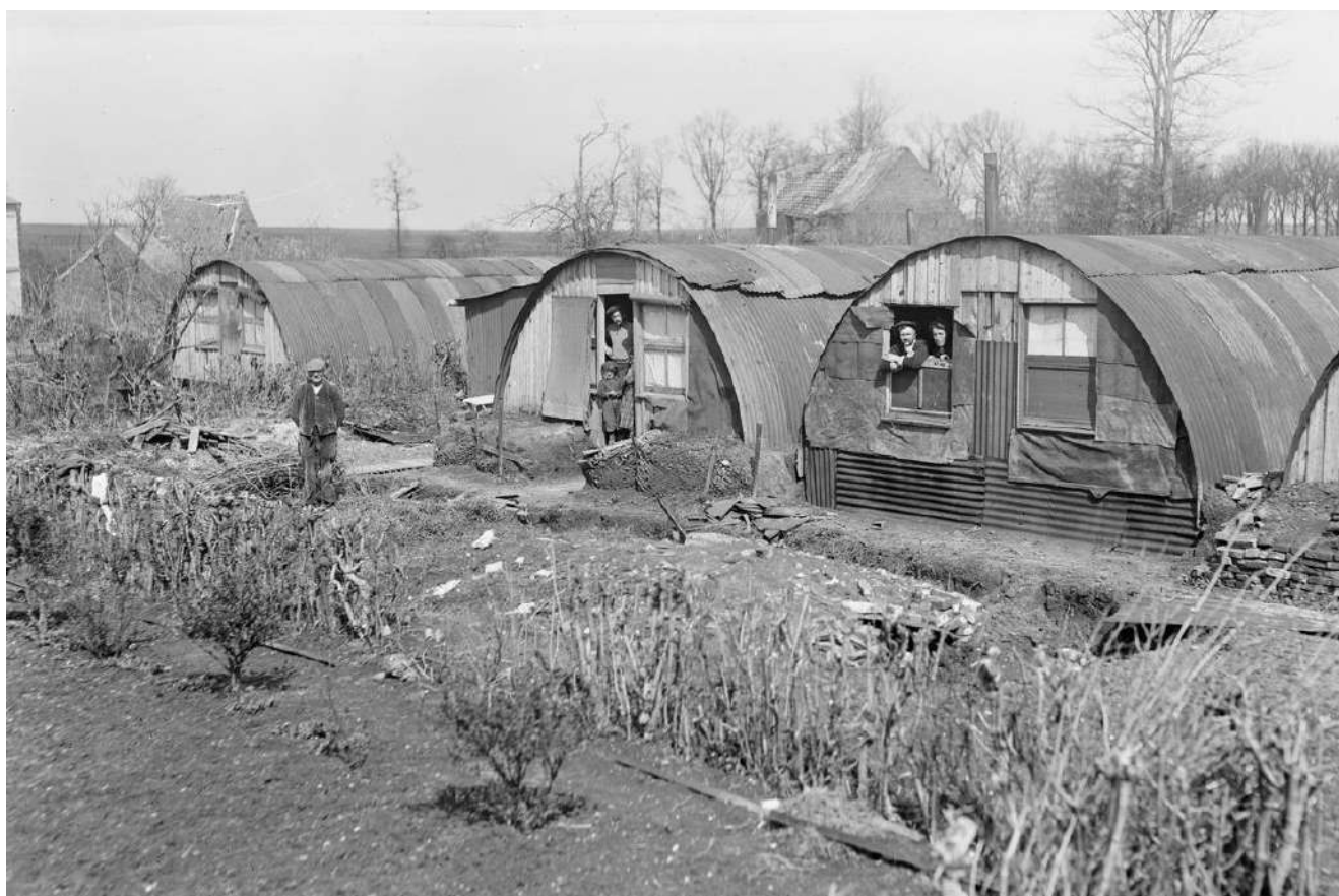
Baraques provisoires Nissen à Equancourt, 13 avril 1919.
