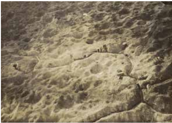
Vue aérienne sur les réseaux de tranchées
